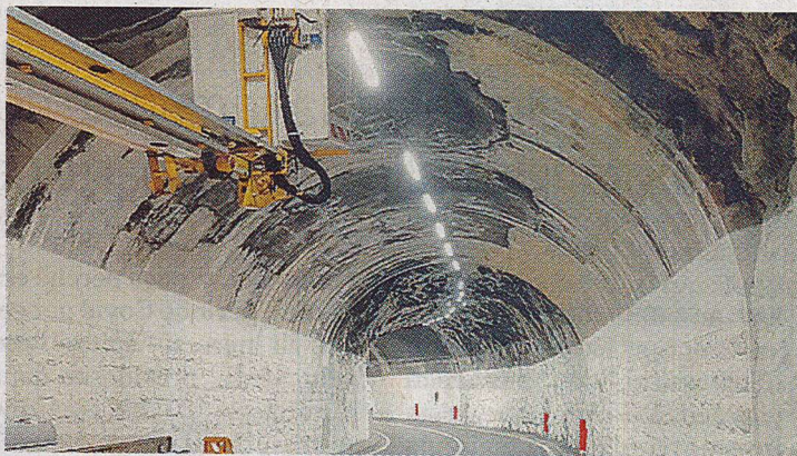
La galleria già tutta illuminata
